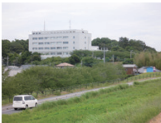
5階建ての利根町役場
