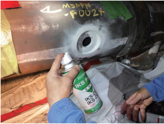
写真2 火力発電所での非破壊検査< PT >
