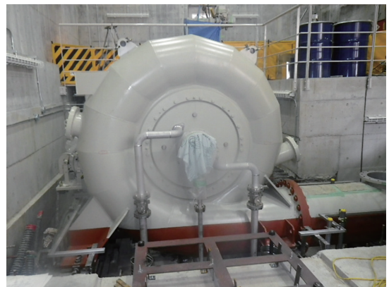
写真 4 小水力発電所のケーシング
