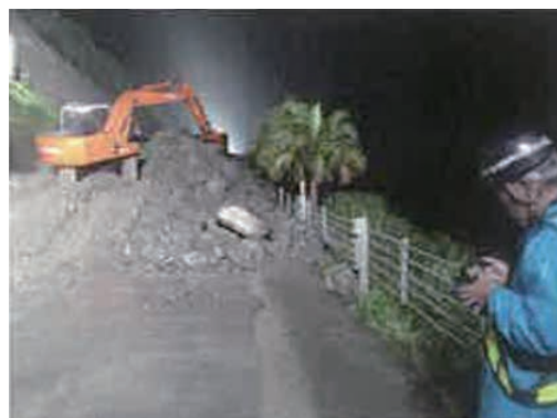
図3 国道220号応急復旧(2017年)
