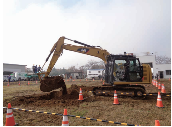
写真5 遠隔施工等実演会(施工DXチャレンジ2022) (遠隔操作体験)
