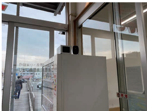
写真 5 宇野港設置の様子（その 2）
