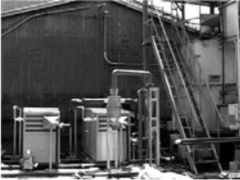
図2 燃焼脱臭発電システムとコンポスト
