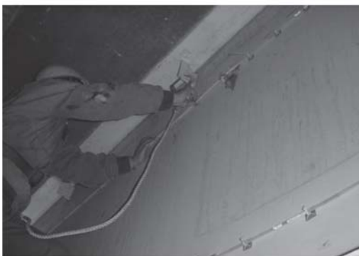
写真1 G1 桁 SOFO センサ設置
