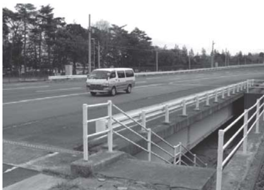
写真4 レーン1 (試験橋梁) 上の走行車
