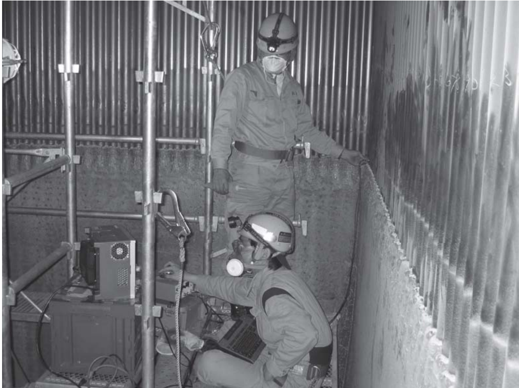
図4 現地計測状況
