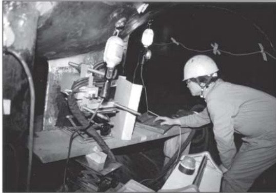
線量が小さいので、狭隘部でも安全に計測が可能 自動計測により、2m以上離れて操作が可能
