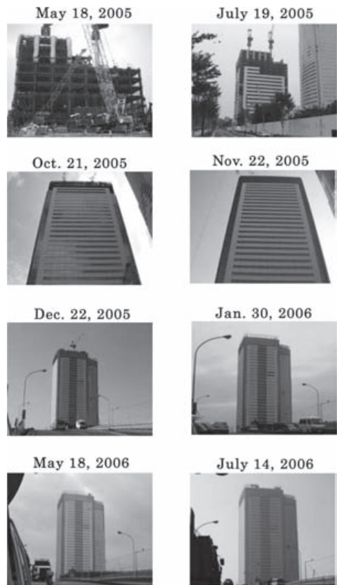
写真4 建設中のビルの写真
