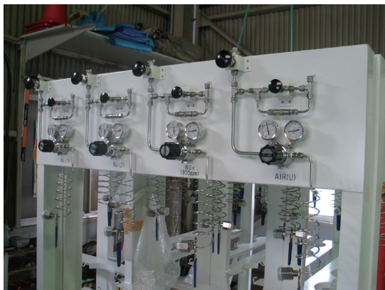
図5 ポンベマニホールド架台機器組付け状況
