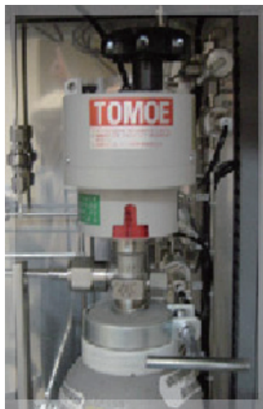
図 4 ボンベ直付け緊急遮断弁
