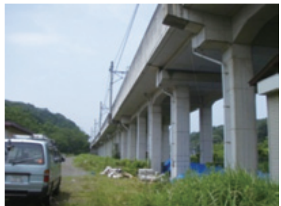
図 19 RC 鉄道高架橋
