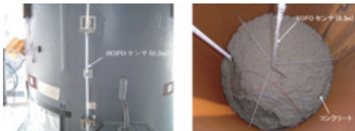
図12 CFT柱へのセンサ設置状況
