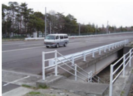
図16 動的載荷試験の様子
