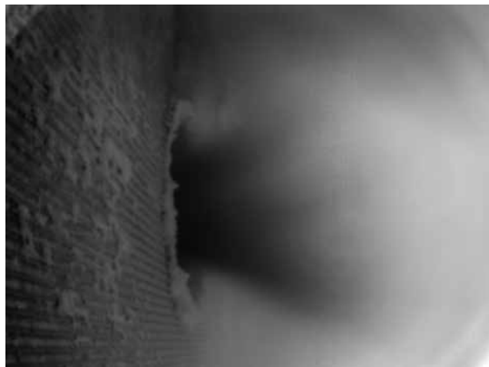
図2 Boiler Spection 映像
