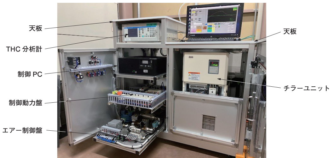
写真5 熱源ユニットメンテナンス状態
